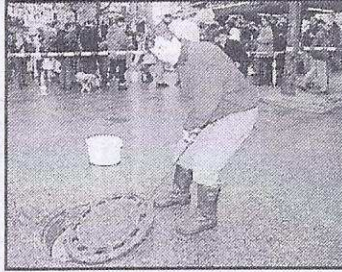
Turnier-Start: Am Kudamm Ek- ke Joachimstaler Straße wird der Gully-Deckel entfernt
